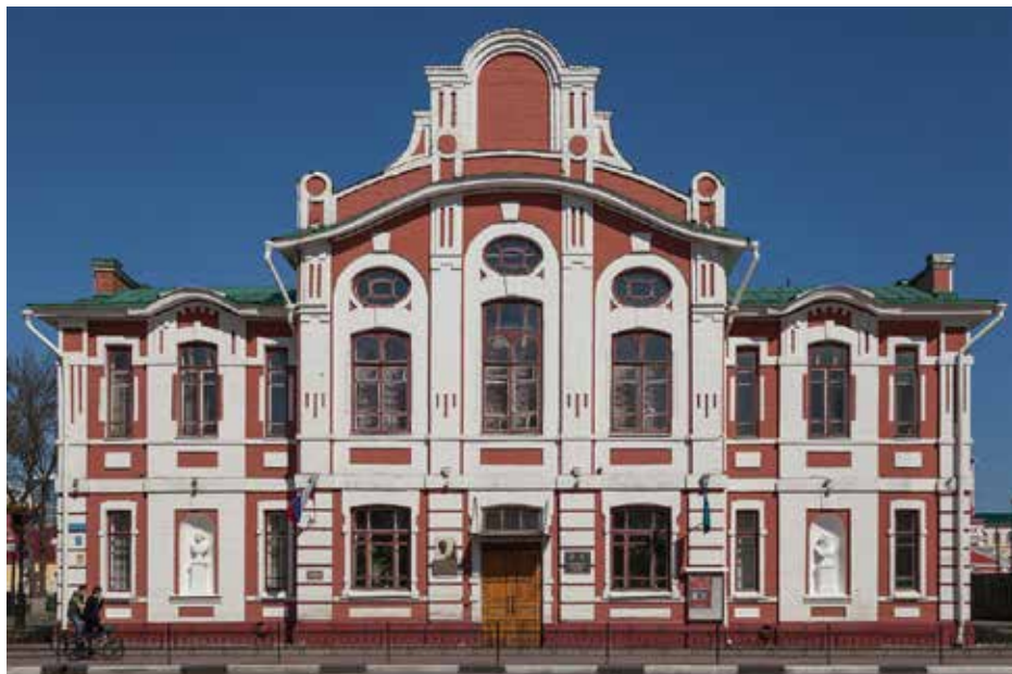
Здание Тамбовского музыкально-педагогического института после реставрации
