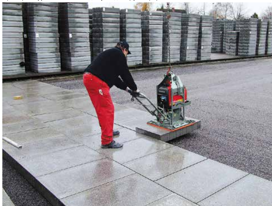
Пример вакуумных захватов для укладки крупноформатных плит
