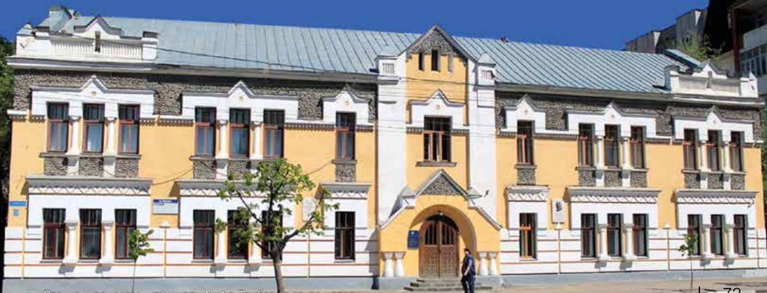
Здание художественной школы № 1 г. Тамбова в стиле модерн. Многие выпускники школы стали студентами, архитекторами
