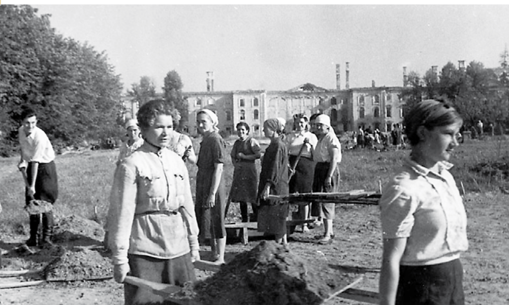
Петергоф. Работы по расчистке Верхнего сада. Фотохроника ЛенТАСС. 1944–1945 гг.
