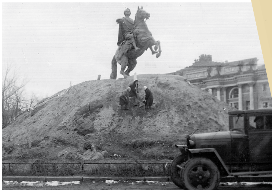
Работы по сооружению защитного укрытия на памятнике Петру I, 1941 г. Фото № 10843 из архива ГМГС
