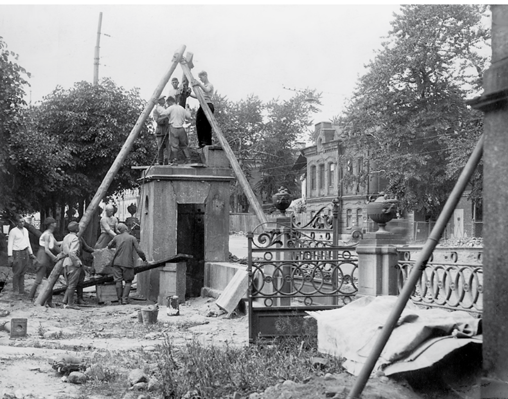
Восстановление ограды Таврического дворца, разрушенной фугасной бомбой. 1943 г. Фотография А.К. Григорьева
