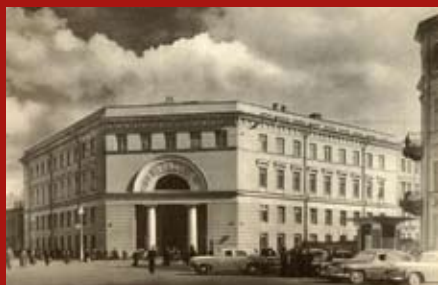
Здание института Ленметрогипротранс со встроенным вестибюлем станции «Владимирская»
